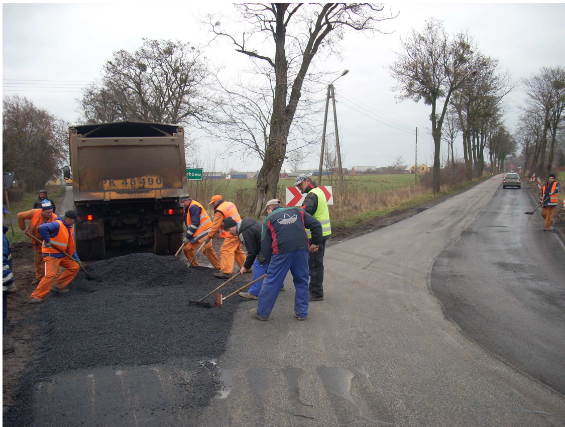
Remont drogi powiatowej Raszków – Pleszew (fot. K. Marszał)
